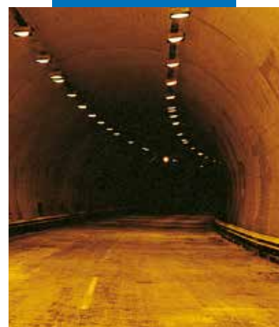
Aplikácia Planiseal 88 biely striekaním v diaľničnom tuneli
