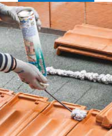
Lepenie strešnej krytiny na pásy
