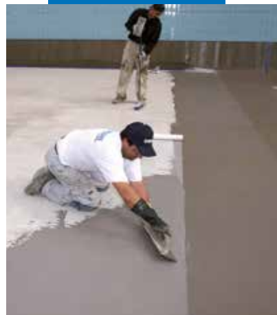
Mapelastic použitý pri izolovaní plaveckého bazéna
