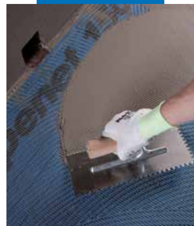
Mapelastic nanášaný na sklotextilnú mriežku Mapenet 150
