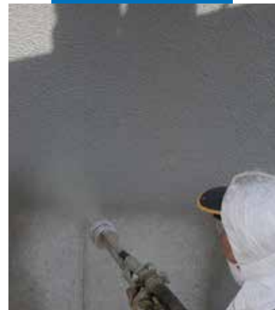
Mapelastic nanášaný nástrekom na viadukte
