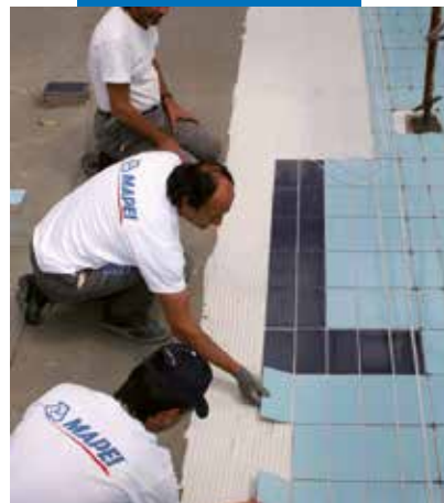
Lepenie dlažby v bazéne na zaizolovaný podklad s Mapelastic
