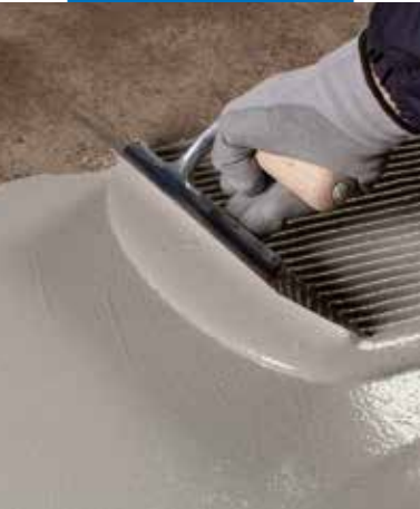
Aplikácia prvej vrstvy Mapelastic Turbo
