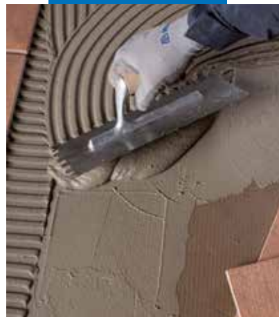
Lepenie dlažby lepidlom Elastorapid
