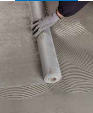
Zapracovanie Mapetex Sel do prvej vrstvy Mapelastic Turbo
