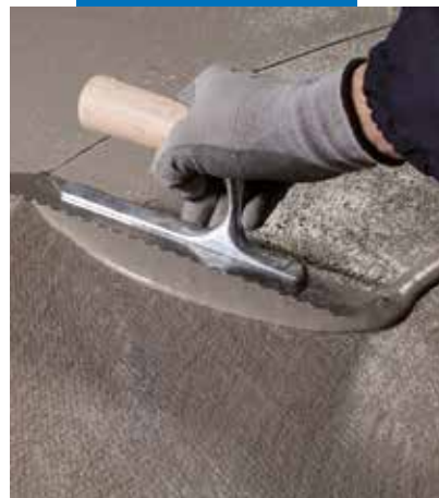
Aplikácia druhej vrstvy Mapelastíc Turbo na prvú vrstvu, vystuženú sklotextilnou mriežkou odolnou proti alkálickým vplyvom
