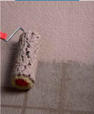
Hydroizolácia terasy valčekom
