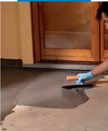
Hydroizolácia terasy stierkou
