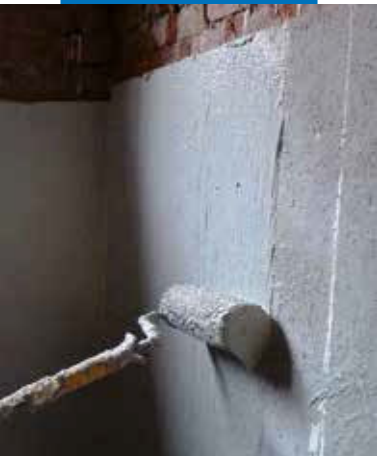
Aplikácia Mapelastic Foundation valčekom na podklad vyhotovený z Planitop HDM MAXI
