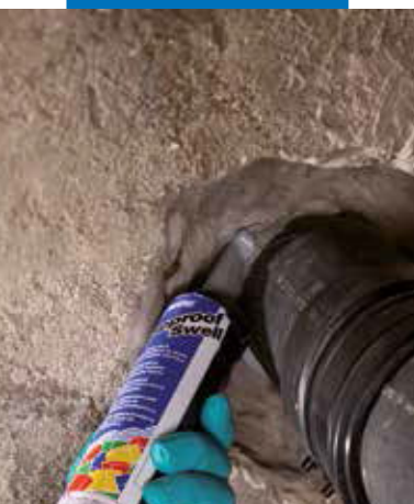
Utesnenie potrubia v stene použitím Mapeproof Swell
