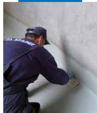
Mapelastic Foundation aplikovaný stierkou proti negatívnej tlakovej vode
