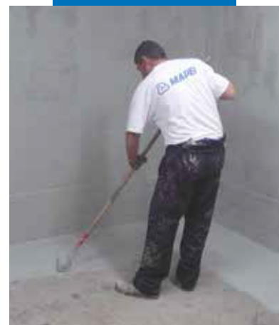
Mapelastic Foundation aplikovaný na podlahe valčekom proti valčekovej vode
