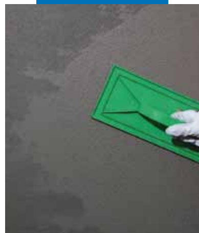
Konečné vyhladzovanie opravnej malty Mapegrout 430
