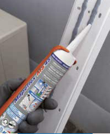
Lepenie plastových profilov v exteriéri
