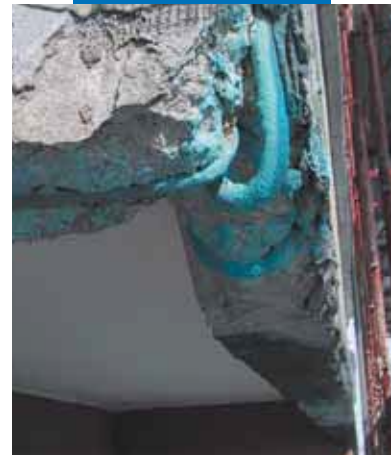
Mapefer 1K aplikovaný na výstužnú oceľ v čele balkónovej konštrukcie
