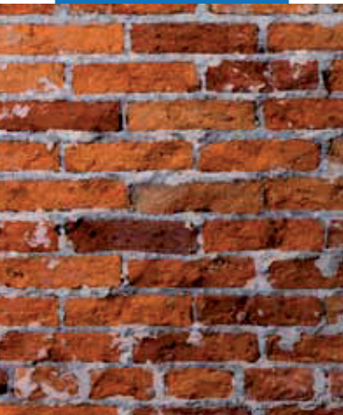
Murivo po odstránení poškodenej omietky
