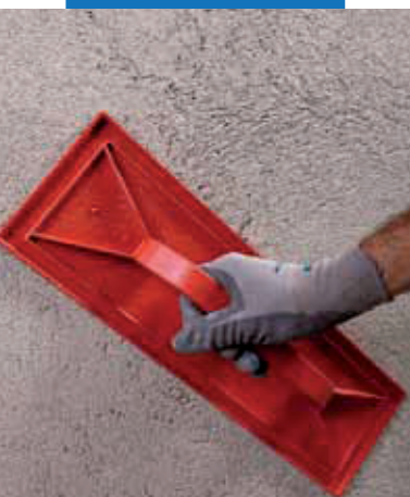
Vyhľadanie povrchu Mape-Antique MC
