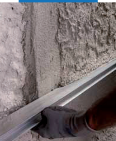
Vyrovnanie Mape-Antique MC zrovnávacou latou
