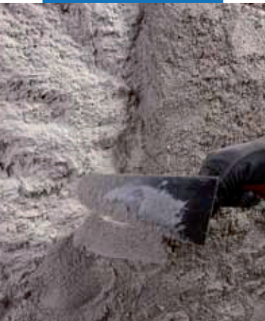
Aplikácia odvlhčovacej omietky Mape-Antique MC na základnú vrstvu Mape-Antique Rinzaffo
