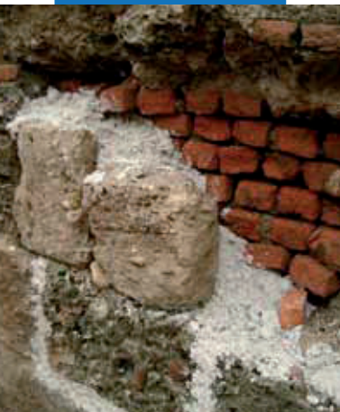
Oprava muriva použitím malty pripravenej priamo na stavbe
