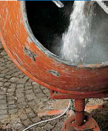
Miešanie malty na stavbe s použitím miestneho kameniva
