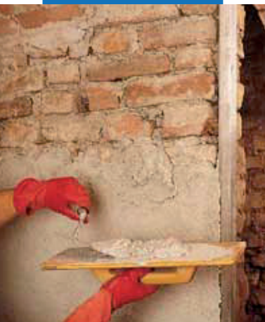
Aplikácia odvlhčovacej ometky Mape-Antique LC
