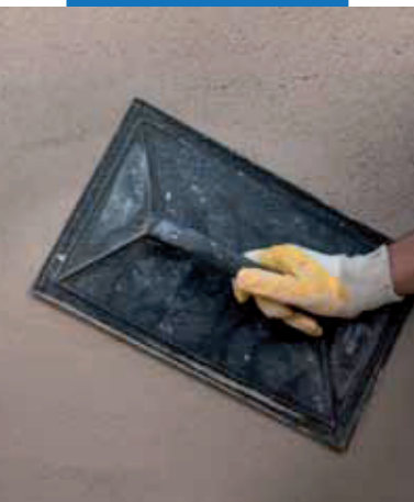
Vyhladenie povrchu omietky Mape-Antique Intonaco NHL
