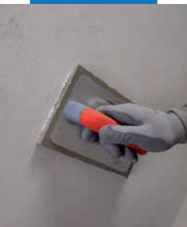
Dokončenie povrchu Mape-Antique FC Civil navlhčeným špongiovým hladičkom
