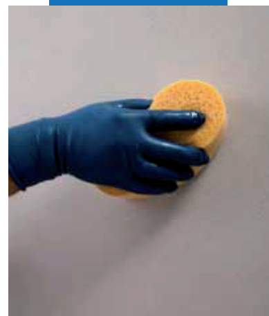
Dokončenie povrchu Mape-Antique FC Civil navlhčenou hubkou
