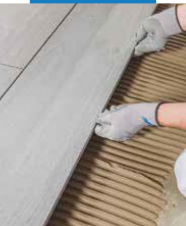
Lepenie dlažby na podklad zaizolovaný s hydroizoláciou Mapelastic
