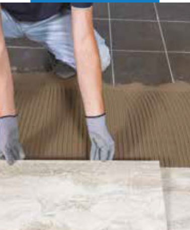
Lepenie kameňa na existujúcu keramickú dlažbu
