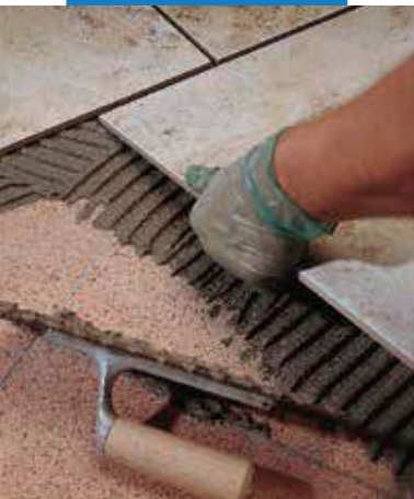
Inštalácia jeden krát vypalovaných obkladových prvkov na podlahe z terrazzo v exteriéri
