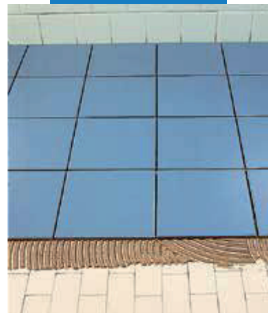
Inštalácia dlažby na dlažbu s použitím lepidla Keraflex šedý
