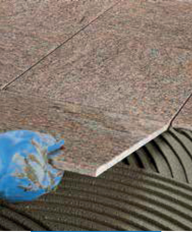
Inštalácia mramoru na podlahe
