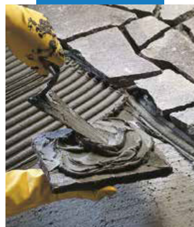
Inštalácia kameňa metódou obojstranného lepenia
