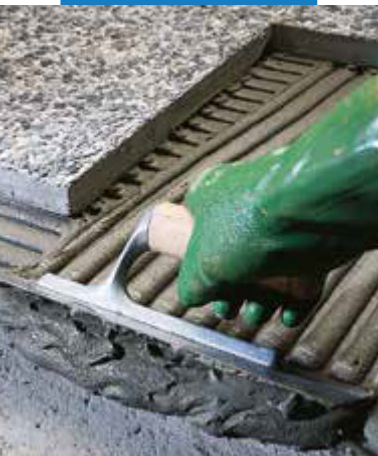
Inštalácia dlažby na terase
