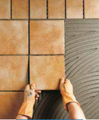
Inštalácia Klinker obkladových prvkov v eteriéri
