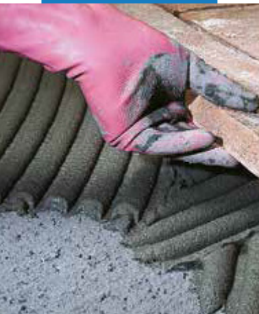
Inštalácia Teracotta obkladových prvkov na nerovnom podklade
