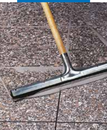
Škárovanie leštenej žuly špeciálnym, gumovým, podlahárskym náradím
