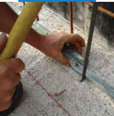
Upevnenie Idrostop B25 do požadovanej
