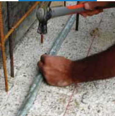
Upevnenie Idrostop B25 do požadovanej
