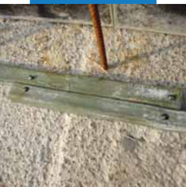
Napojenie dvoch pásov Idrostop B25 s presahom
