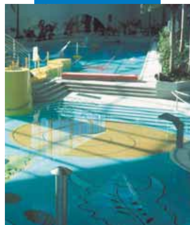
Príklad inštalácie mozaiky a klinkera v plaveckom bazéne
