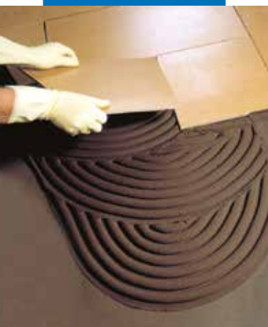
Inštalácia porcelánovej dlažby na poter zaizolovaný membránou Mapelastic
