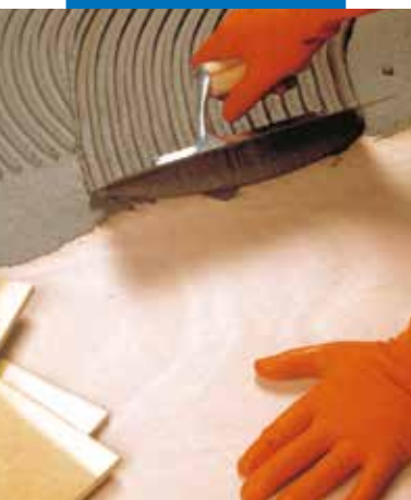
Inštalácia porcelánovej dlažby na lodnú preglejku lepidlom Elastorapid
