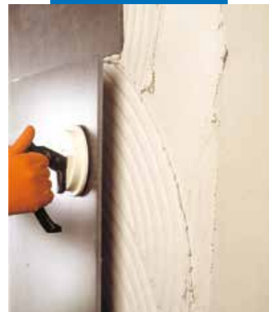
Inštalácia veľkoformátovej porcelánového obkladu na fasádu lepidlom Elastorapid
