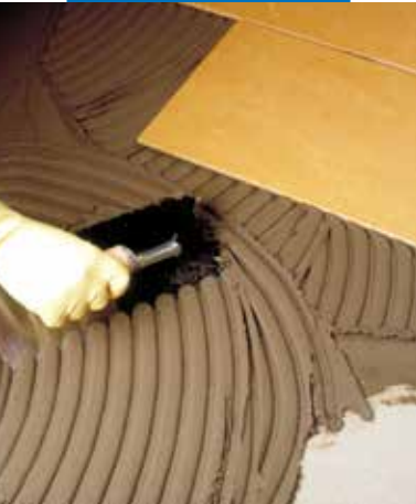
Nanesenie lepidla Elastorapid na cementový poter zubovou stierkou
