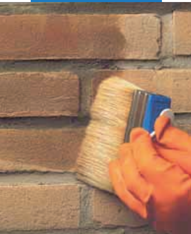
Aplikácia náteru Antipluviol S štetcom
