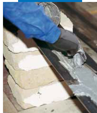
Aplikácia Adesilex PG1 na kovovej platni
