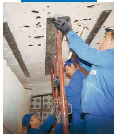
Inštalácia kovovej platne pre zosilnenie konštrukcie
