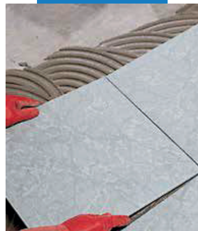
Inštalácia porcelánovej dlažby
