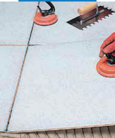
Inštalácia veľkoformátovej dlažby
