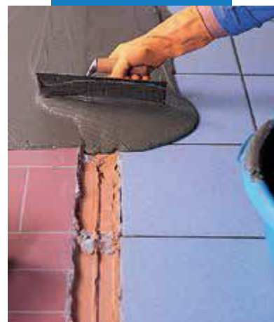
Vyrovnanie stávajúcej podlahy s Adesilex P4
