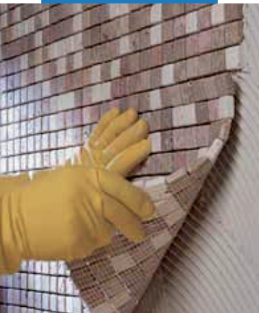
Inštalácia mramorovej mozaiky na stenu
