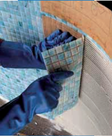
Inštalácia sklenenej mozaiky 2x2 cm v plaveckom bazéne s lepidlom Adesilex P10 zmiešaným s prísadou Isolastic a vodou v pomere 1:1
