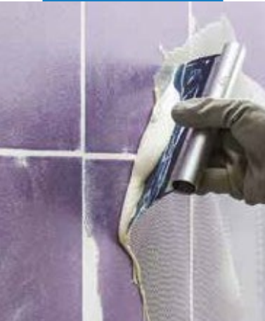
Nanesenie Ultrabond Eco MS 4 LVT Wall s použitím zubovej stierky na nesavý podklad
