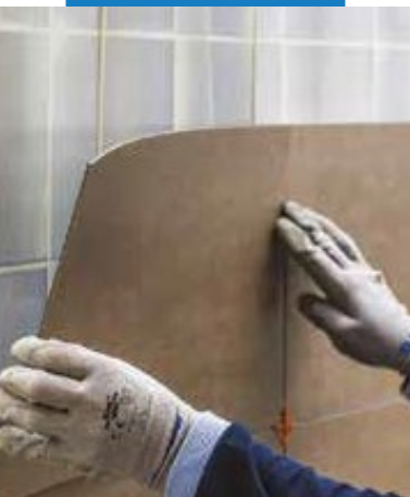
Inštalácia LVT krytíny na stenu
