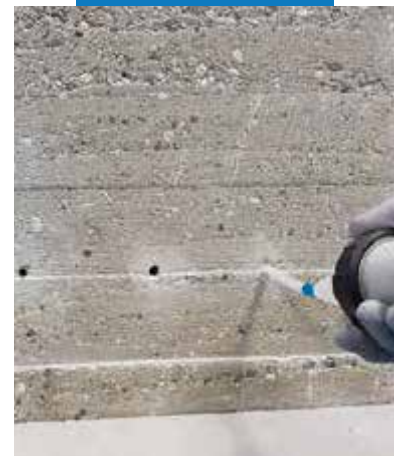
Vyhotovenie chemickej bariéry v betónovej stene
