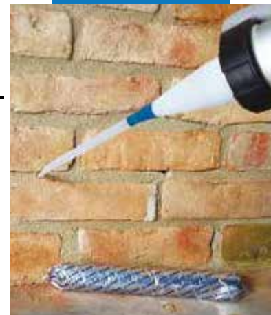
Vytlačenie krému zo salámového balenia s použitím pištole a výplň otvorov
