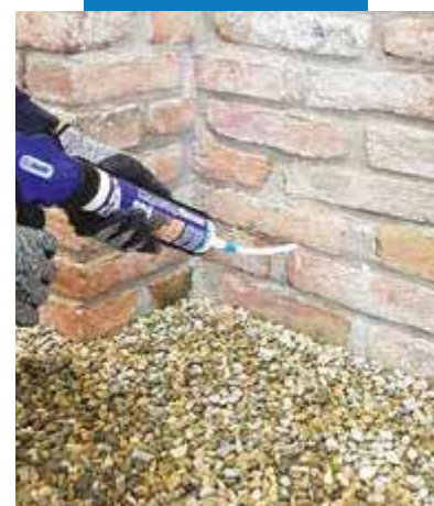
Vytlačenie krému z kartuše s použitím pištole a výplň otvorov
