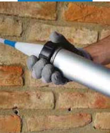
Osadenie príruby k pištole
