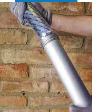
Vloženie „salámového“ balenia do vytlačacej pištole a zrezanie špičky salámy
