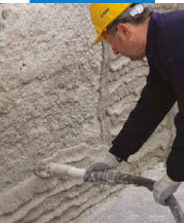
Aplikácia Poromap Deumidificante omietacím zariadením
