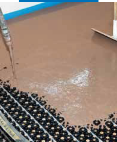
Čerpanie a vyhladenie zmesi Novoplan Maxi
