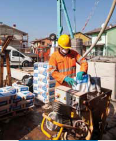
Príprava a čerpanie zmesi Novoplan Maxi s použitím strojného zariadenia s kontinuálnym miešaním
