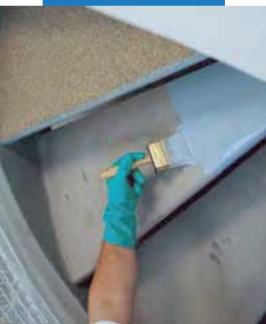
Mapecoat I 24 aplikovaný štetcom na betón v prvej vrstve
