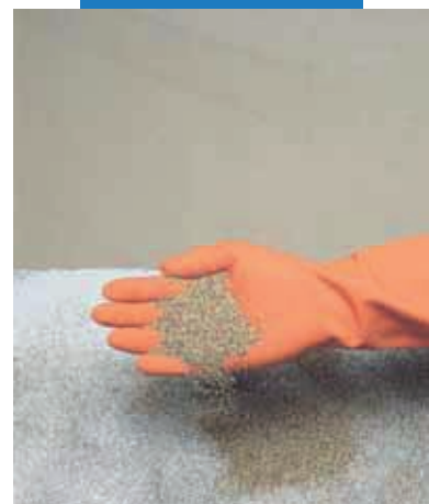
Presyp prvej vrstvy náteru Mapecoat I 24 kremičitým pieskom
