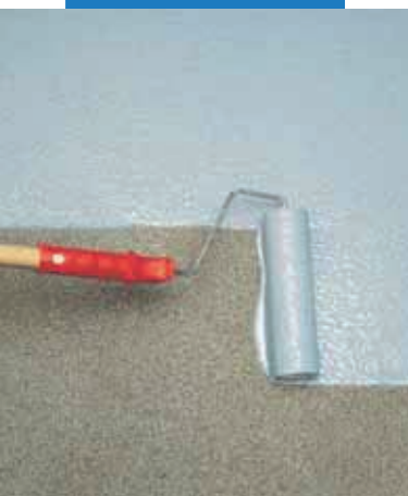
Mapecoat I 24 aplikovaný valčekom
