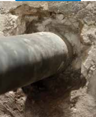
Mechanické príprava priestoru okolo potrubia
