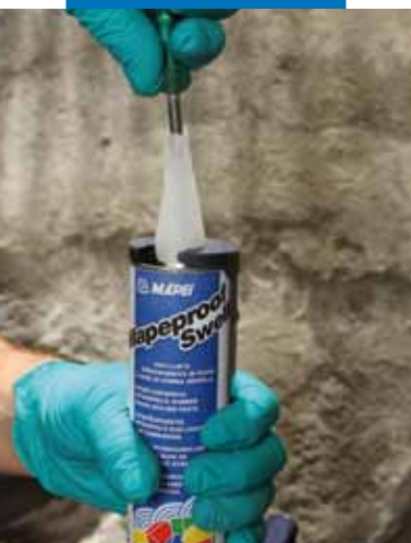
Vyhotovenie otvoru do ochrannej membrány v špiči
