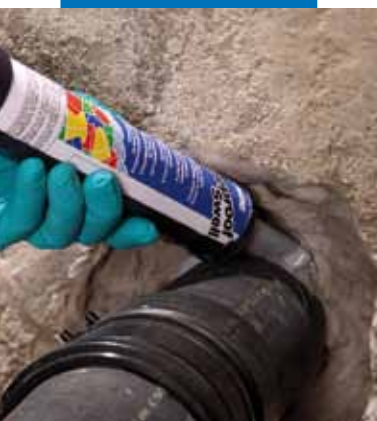
Aplikácia Mapeproof Swell okolo potrubia
