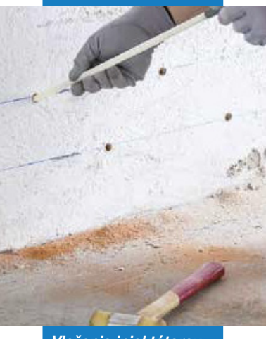
Vloženie injektátorov do otvorov
