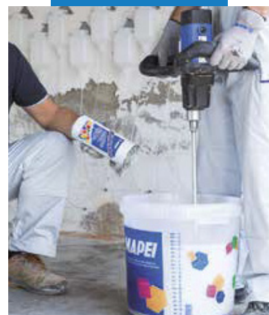
Príprava injektážnej zmesi
