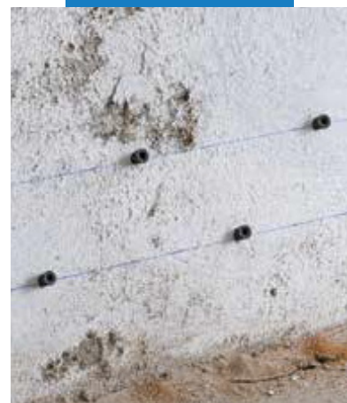
Detail osadených injektátorov
